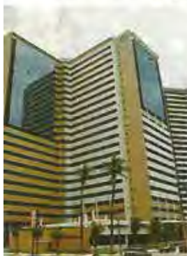
Fachada do Holiday Inn Fortaleza.
